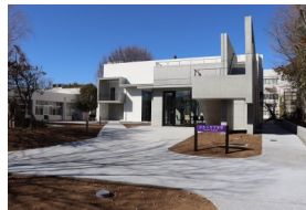
シミックプラザ外観
